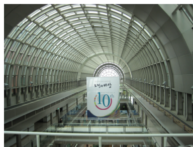
エントランス天井
